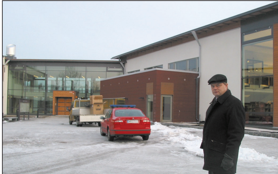
Kaupunginjohtaja Jari Jussinmäki kertoo, että paimiolaisilta on tullut erittäin positiivista palautetta uuden kaupungintalo-kirjaston suunnittelusta. Kuvaa otettaessa rakennuksen viimeistelytyöt olivat vielä kesken.
